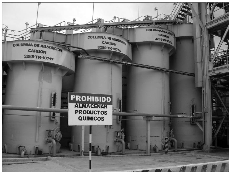
Рис. 8. Линия сорбционных колонн на фабрике Кинуа
