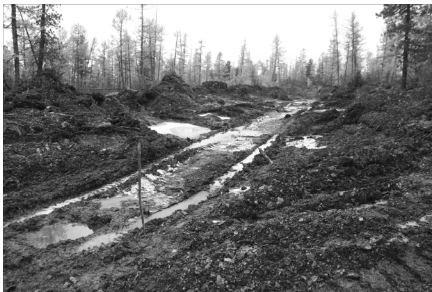
Рис. 2. Проходка шурфов глубиной 1 м (залиты водой) по бульдозерной канаве глубиной <1 м после оттайки делювия, Атырканская площадь
